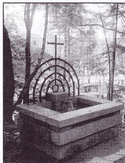
Odremonowana studnia na cmentarzu przy ul. Kaszubskiej
