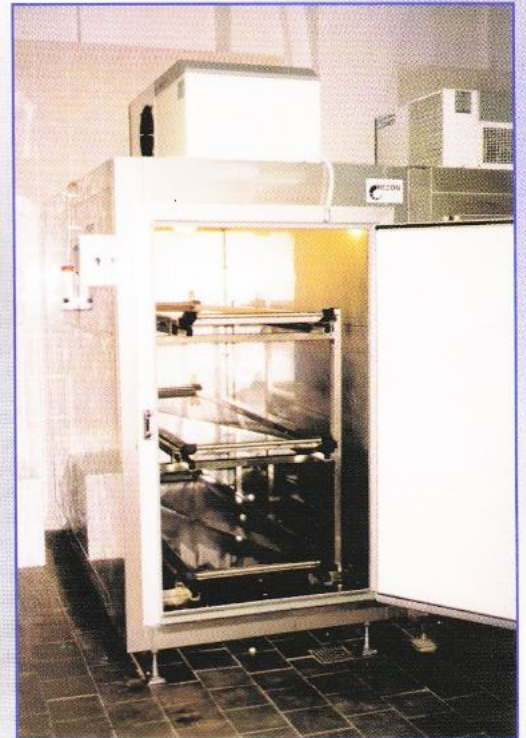
ROK 2001 KOMORA MROŹNICZA (-20 C) NA 3 CIAŁA NA TACACH - ZAKŁAD USŁUG KOMUNALNYCH SZCZECIN
